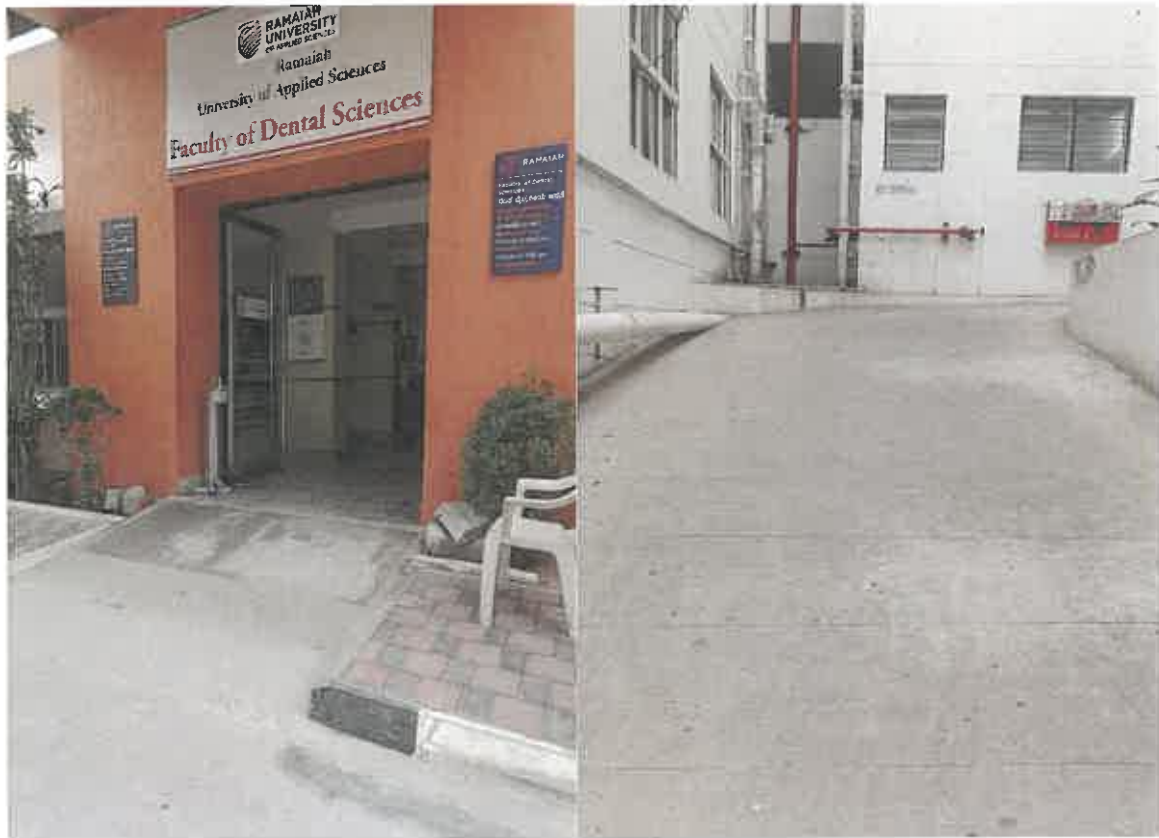
Non slippery ramps
