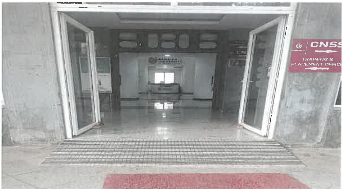
Non slippery ramps
