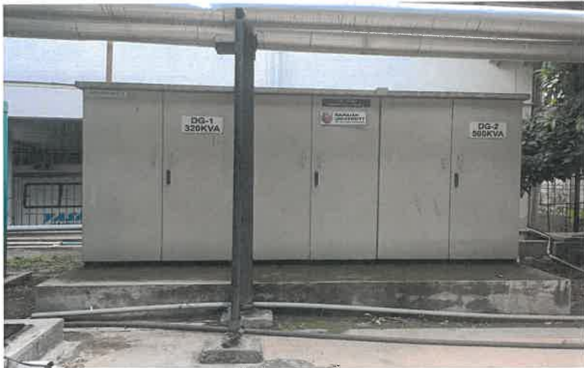
500 KVA DG Set
